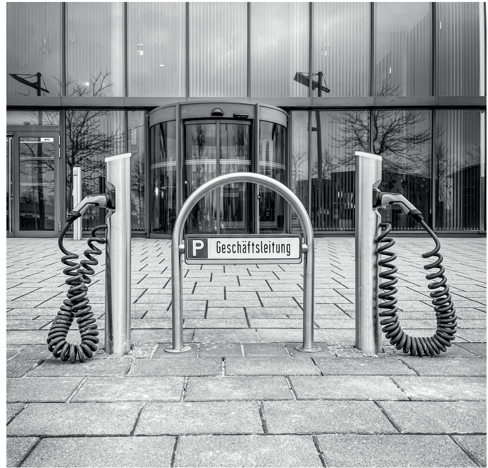
KANAL-TOWER, OSTERRÖNFELD, SCHLESWIG-HOLSTEIN
